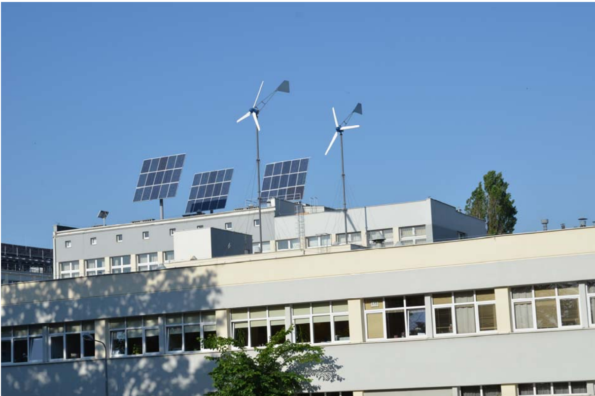
Rys. 3. Odnawialne źródła energii w Laboratorium Generacji Rozproszonej
